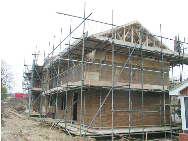
Hampehus under konstruktion.
