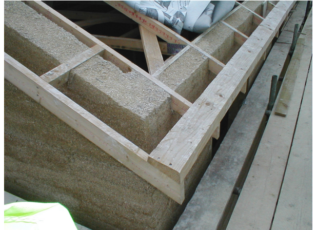
Vægge møder tagkonstruktion
